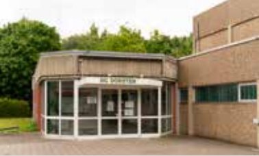
Anstehender Neubau der Juliusshalle
